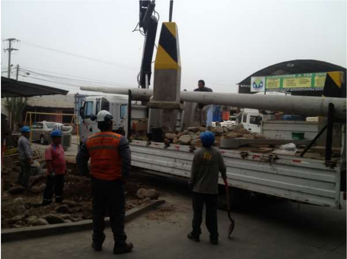
MONTAJE DE POSTES PARA SAB DE 500KVA
