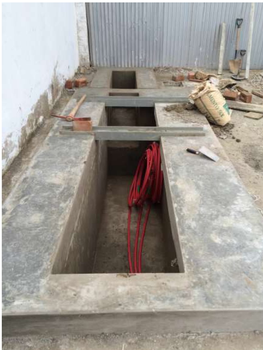
OBRAS CIVILES PARA BASE DE SUBESTACION.
