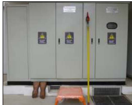
SUBESTACIÓN COMPACTA INDUSTRIAL CON TRANSFORMADOR AISLADO EN ACEITE
