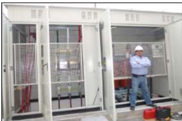
SUBESTACIÓN COMPACTA PARA COLEGIOS, HOSPITALES, etc. CON TRANSFORM. SECO
