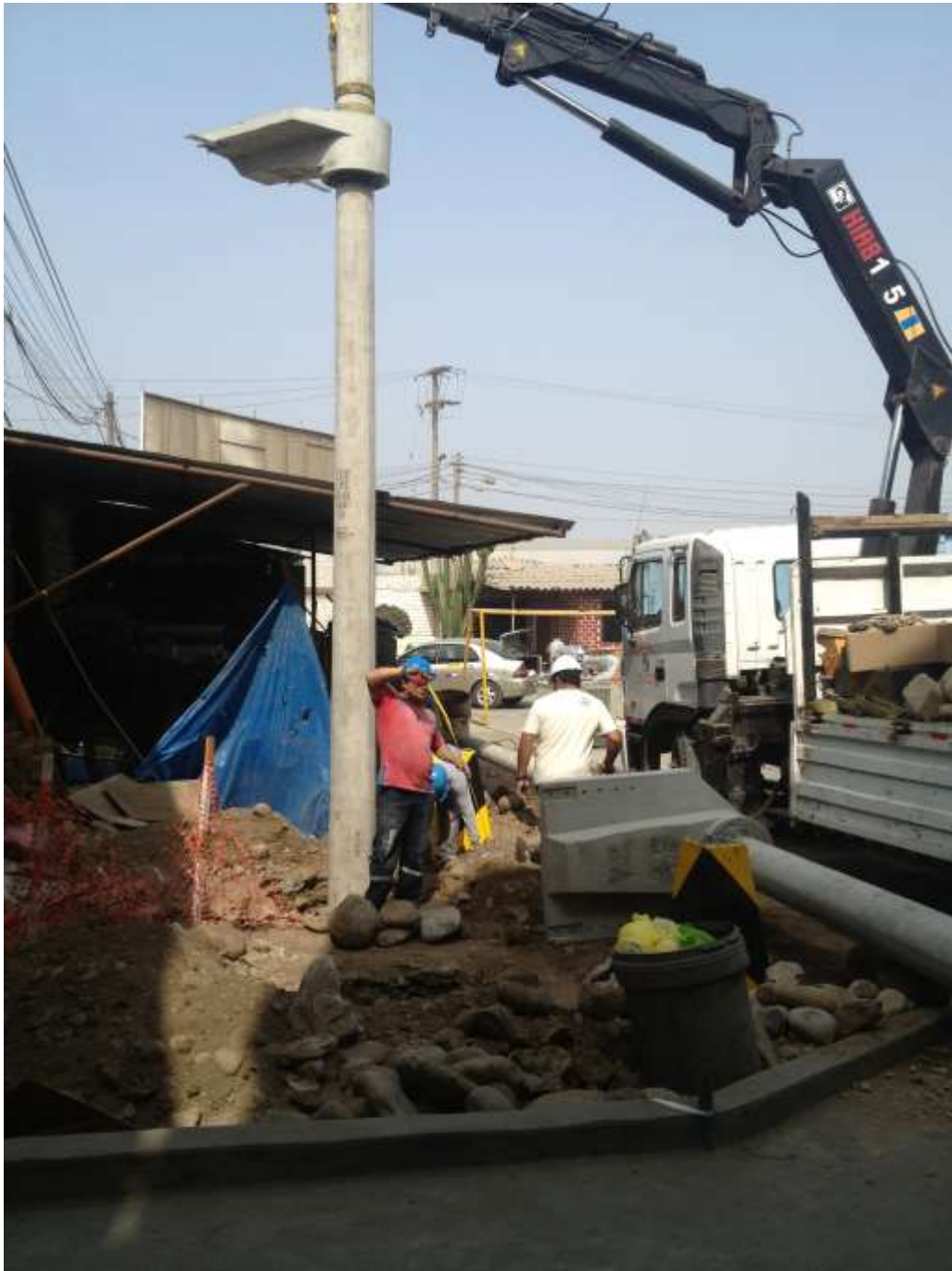
IZADO DE POSTES
